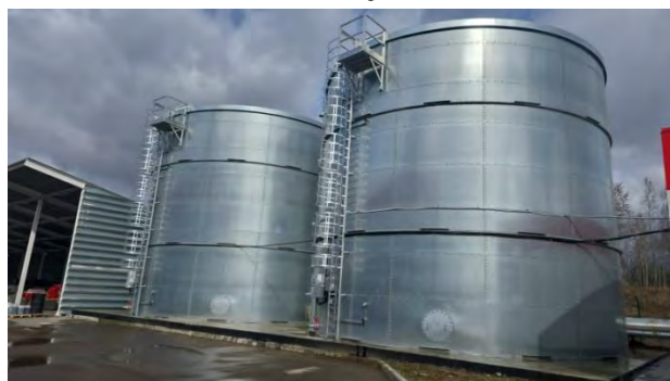
Фото № 26. Насосная станция пожаротушения
